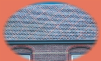
Detail dak van De Cantine.
